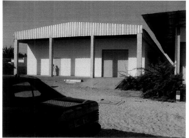
MSAS の中央倉庫。医薬品が保管されている。十分な広さをもち、蚊帳と殺虫剤はここに一次的に保管される。
