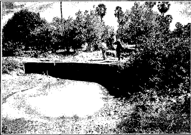
幹線水路にかかる橋
