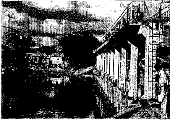
写真① 頭首工上流側右岸から撮影
