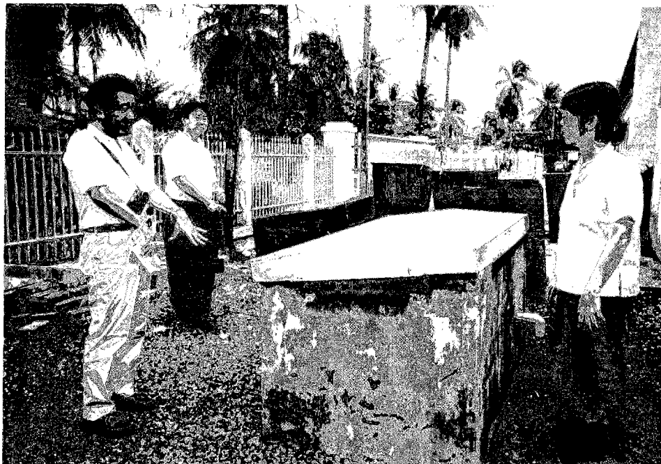
国立母子保健センター内視察① (敷地内にあるバックアップ用の井戸)
