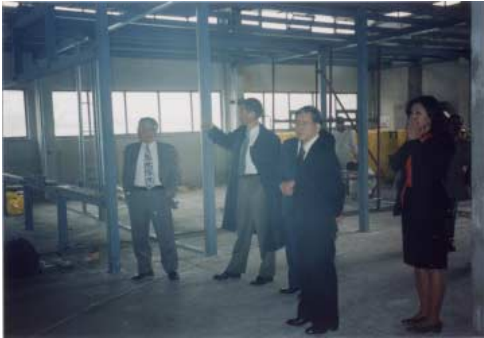
JICA 省エネルギープロジェクト現場視察 (ミニプラント建設現場)
