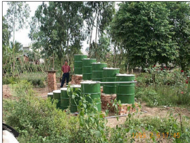
接触浄化法実施プラント
