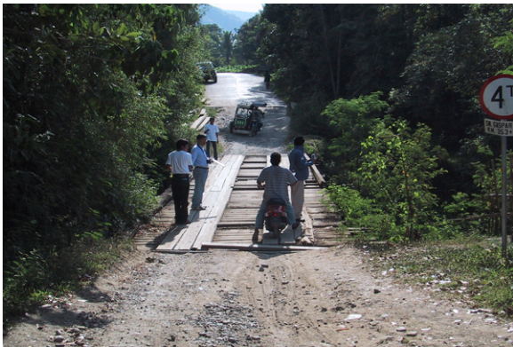
Ilocos Sur 州 01-02-01 San Gasper II 橋
