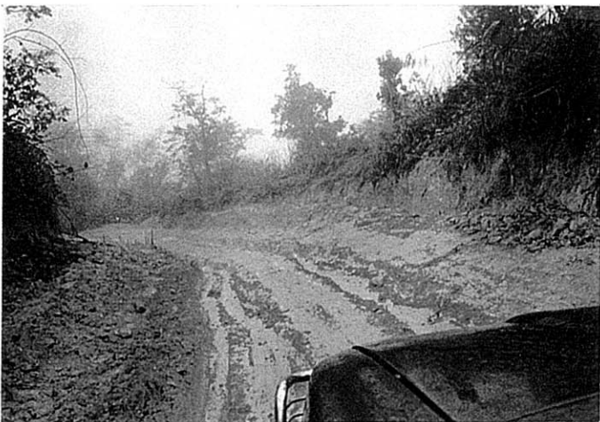
幹線(雨期) 泥土化地点
