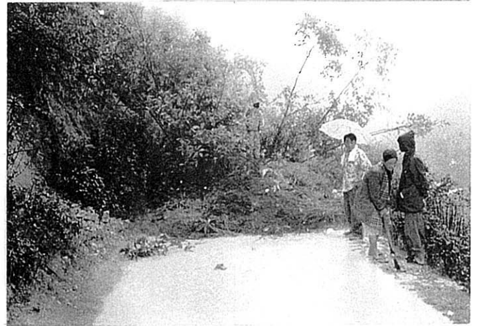
幹線(雨期) のり面崩壊地点
