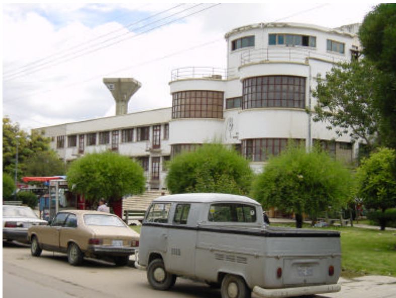
現ヘルマンウルキジ病院：敷地東側からの外観
