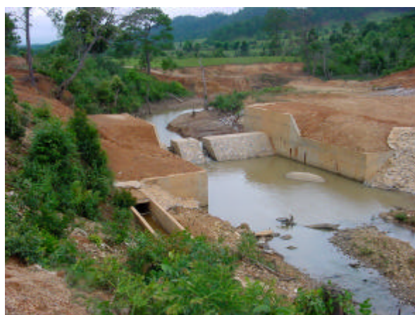
受益者運営灌漑開発事業 (CMISP) により建設された頭首工 (シェンクアン県)
