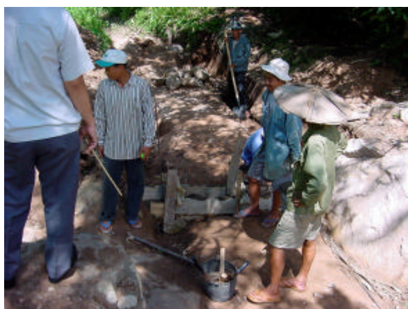
農民参加による水路建設 (ウドムサイ県)
