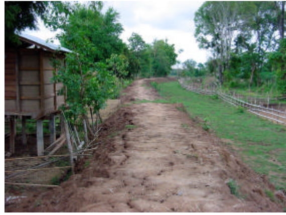
洪水防御堤 (サバナケット県)
