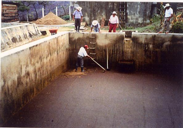
緩速ろ過池のろ過砂削り取り風景
