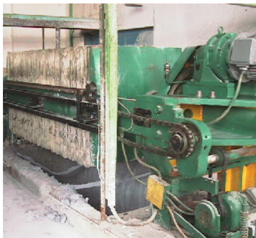
図 -3 カーバイド泥圧縮濾過設備
