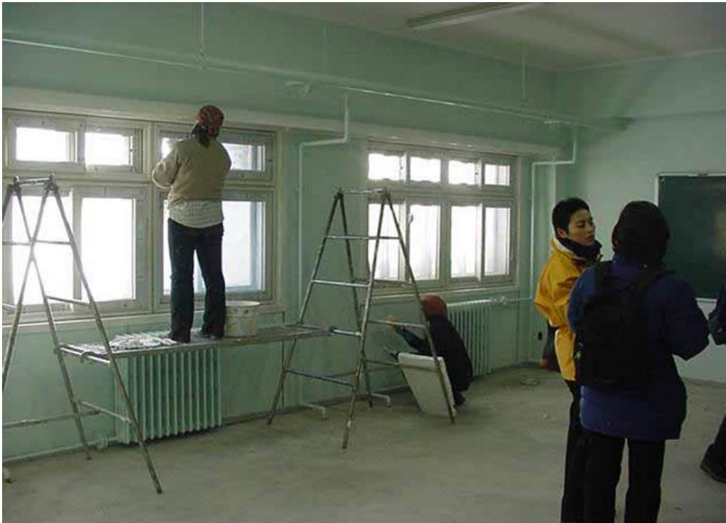
第一次初等教育施設整備計画建設現場(ウランバートル第13学校)
