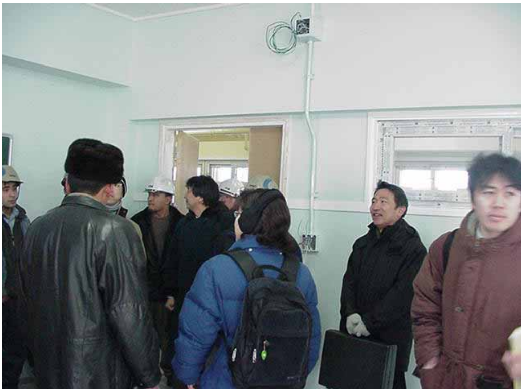
第一次初等教育施設整備計画建設現場(ウランバートル第13学校)
