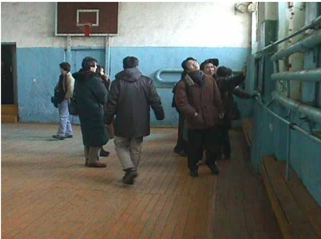
暖房設備が壊れ冬季使用不可の体育館(ブルガン県ダシンチレンソム)
