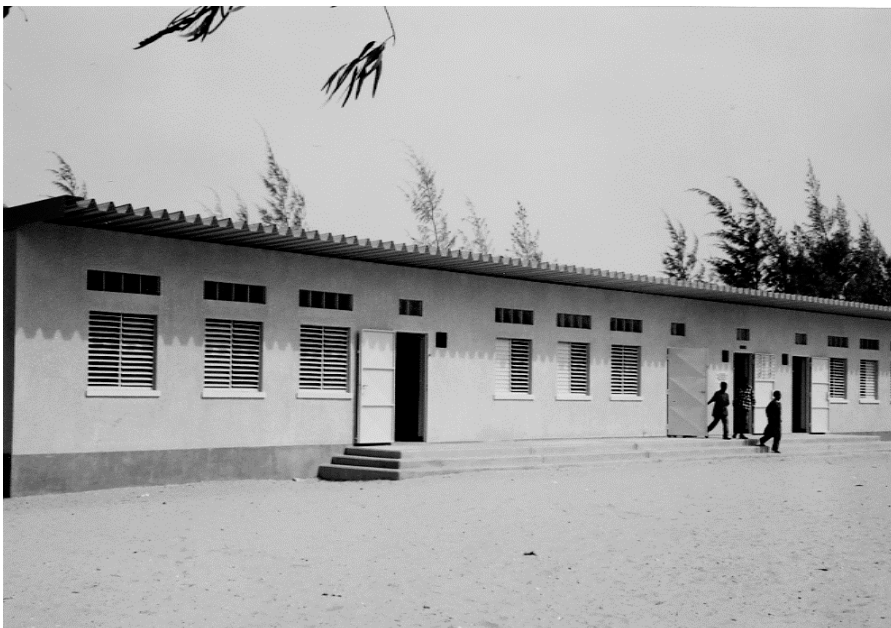
日本の協力（2次）で建設された教室 ダカール州、ダカール州、ルフィスク 2
