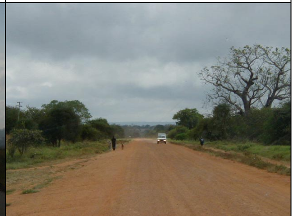
国道 B7 号線 8m 幅の砂利道であるが、走行上の支障はない
