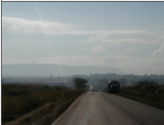
国道 A109 号線、 約 8m 幅のアスファルト舗装
