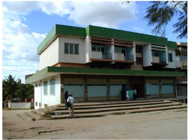
写真4 ナンプラ州医薬品倉庫
