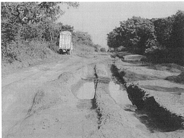
写真-41 国道3号線② 未舗装区間は、降雨により侵食され、わだちが発生し交通障害を引き起こす。
