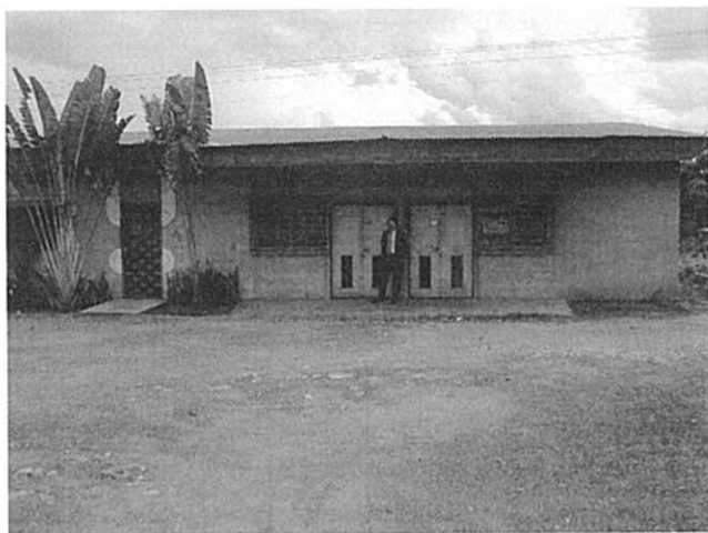
写真-35 保健省のワクチン倉庫 個々から全国の病院に配布される。1990年にUSAIDにより建設され、その後Unicefにより修復された。
