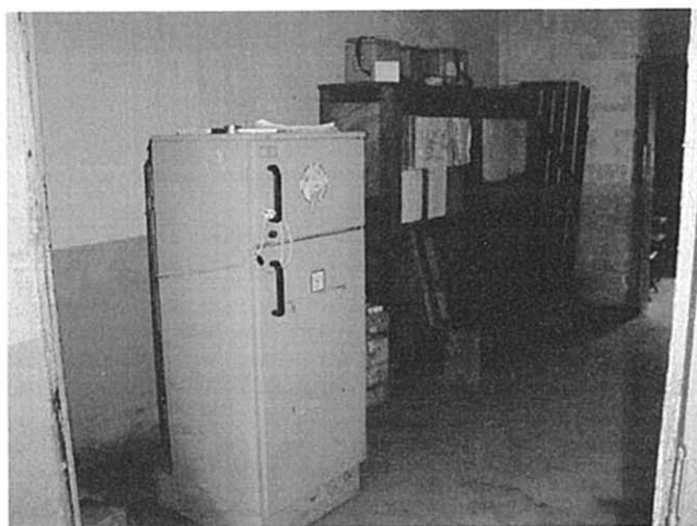
写真-23 Baoro郡病院にある冷蔵庫 予防接種用に日本のマルチバイ協力により1998年に供与された。電気がないためアブソープションタイプ(石油)である。
