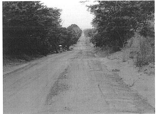
写真-40 国道3号線① 内陸国である「中ア」唯一の輸出入道路であり、カメルーン国ドゥアラ港に通じている。現在、日本の無償資金協力で完全舗装化が図られているが、現在一部区間で未舗装である。2002年に全面舗装化される予定である。
