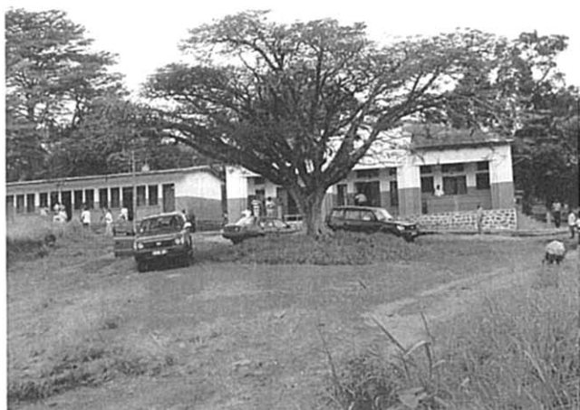
写真-1 Mbaiki県病院の外観 平均日に30人ほどの外来患者が訪れる。
