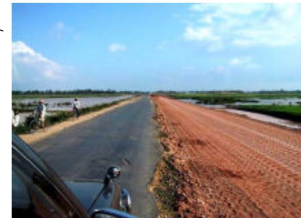
国道1号線 ADBによる整備工事 （スパイリエン州）
