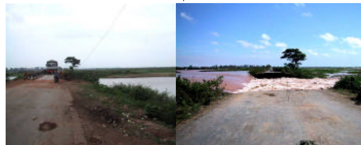
国道1号線 メコン河増水による決壊とその後の修復状況 （カンダール州）
