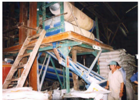
長さ選別機 導入が始まったばかりで、装備している精米所は限られている。適正な使用法が十分に理解できていないケースが見られた。
