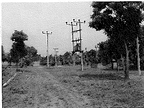
電柱作業用施設
