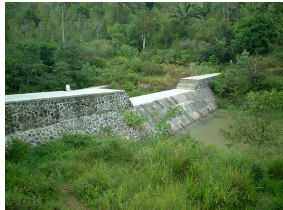
Dam Pengendali Tipe Tanggul Genangan Gravitasi di Touliang Oki
