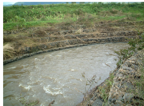
Pekerjaan Penanganan Aliran Deras yang Efektif di Sungai Panasen, H=2.5m
