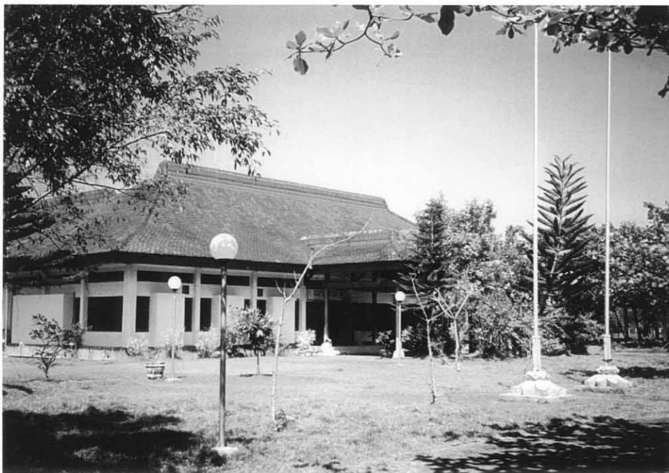
マングローブ情報センター全景
