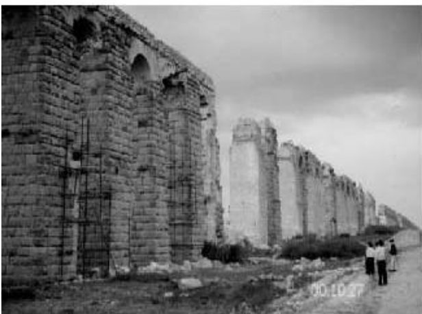
水道橋遺跡： 高さ約12m、全長100km以上の壮大な上水施設。 崩壊が激しく、修復も追いつかない。足場は補強材として使用されている。
