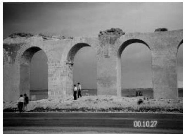
水道橋遺跡： 国道脇に同遺跡があり、車両による振動及び風圧による崩壊が進行している。
