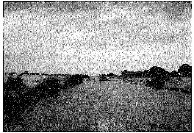
SONO地区パイロット地（230ha）の取水口
