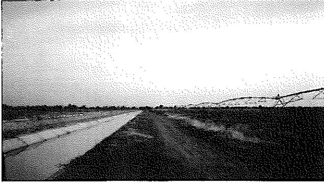
SONO地区パイロット地（210ha）の整備されたかんがい用水路とスプリンクラー
