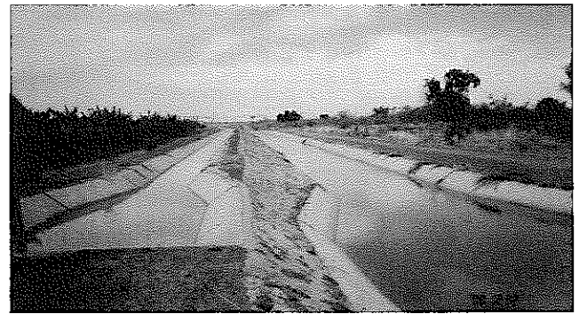
同左 圃場への幹線水路 (遠くにスプリンクラーの施設が見える)
