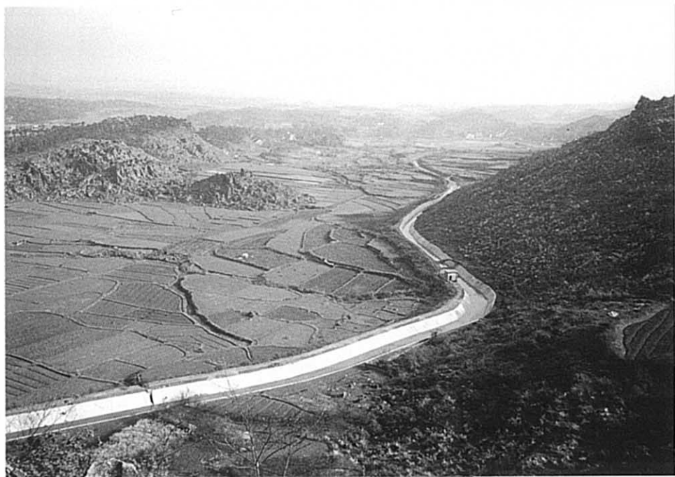
城郊郷 改修後の灌江既設幹線水路 (コンクリートライニング、三面張り)
