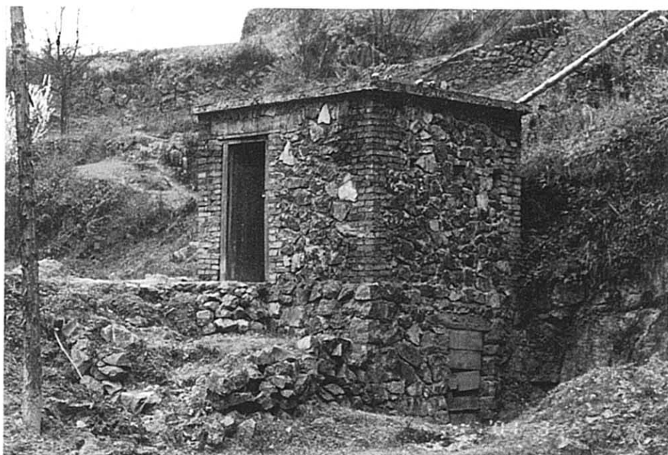
全州県から工事費の約7割の補助を受け整備された ポンプ圧給水施設
