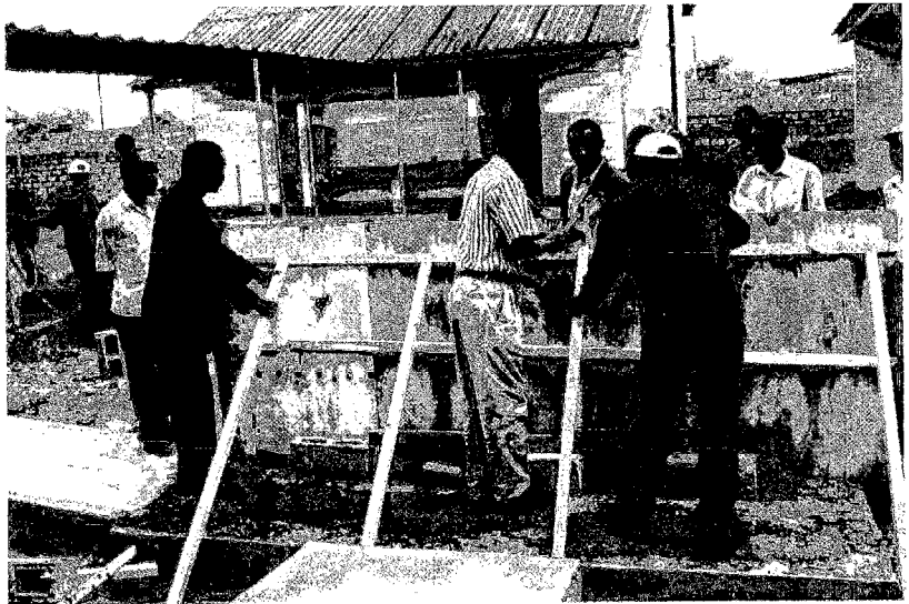
学校の手洗い場取り付け作業
