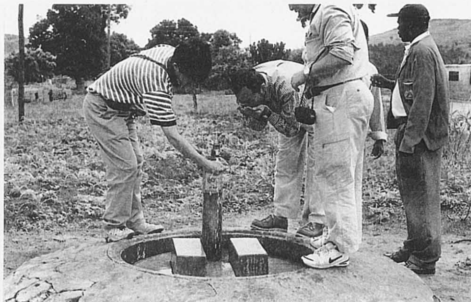
写真6 第1次地方給水計画事業 マクロスキーム公共水栓 Hhohho 県 Bekhinkosi
