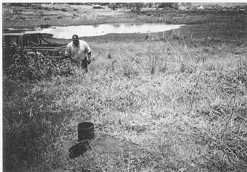
写真8 第2次地方給水計画 マクロスキーム要請 Lomahasha 地区計画 地下水源候補 地質調査・鉱山局建設 試験井 No.5 (石の投げ込みにより 井戸内埋設)
