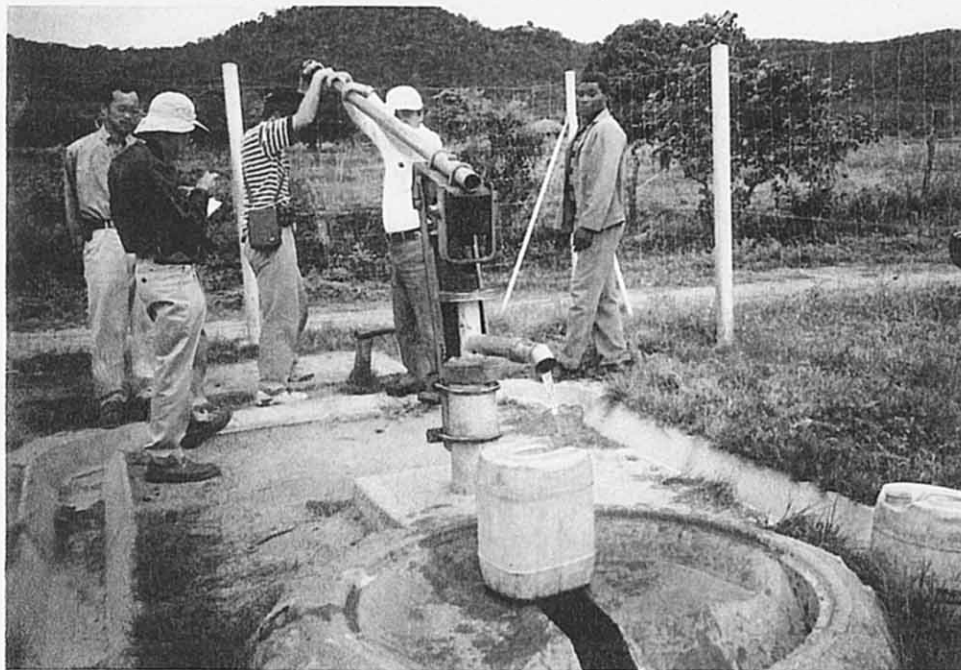
写真2 第1次地方給水計画事業 ミクロスキーム (Bush Pump 付き深井戸) Manzini 県 Emnyokantoka
