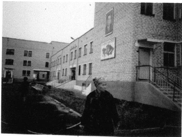
写真(25)：クジルオルダ市より車で1時間程のところに あるシルダリア地区中央病院。TSRBの一つで170床の 病院である。
