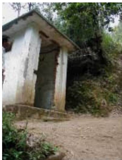
使われていないガードハウス この横に新規配水池を建設する 予定
