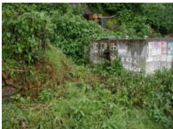
既存の配水池
