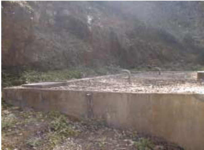
ピヤティサプラ配水池
