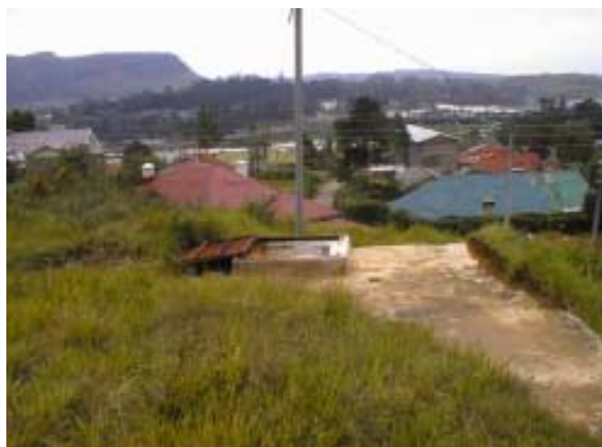
ハドンヒル配水池
