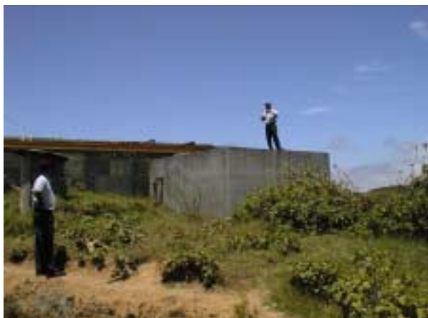
既存の配水池 手前が新規配水池予定地
