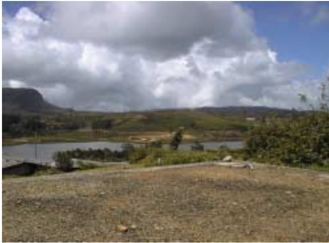
ボナビスタ配水池
