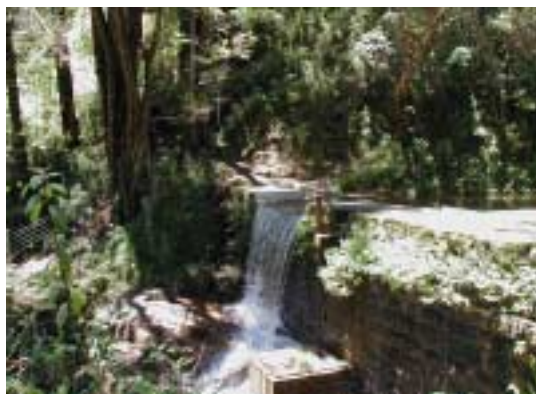
既存の取水堰
