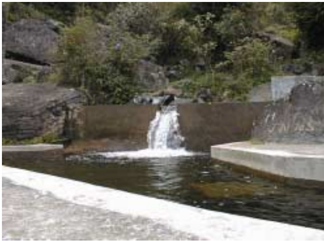
ラバースリーブ取水
