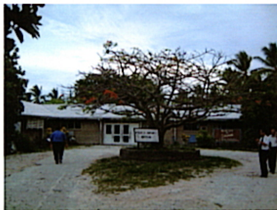
▲既存病院(FM0)の正面部 正面は患者待合ホールのエントランス部で、右側に内科・外科診察室、処置室、歯科診察室と並んでいる。
