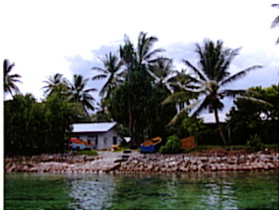
▲内海(ラグーン)側から見た既存病院(FM0) 正面は建設計画地で、現在、解体予定の既存建物がある。海岸線側は、コンクリート製六角きブロック護岸によって海岸侵食防止がなされている。
