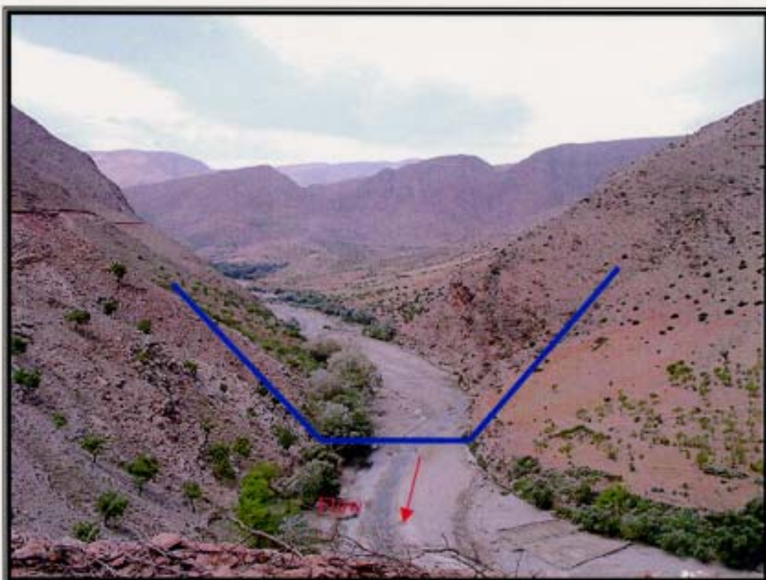
Taskourt ダム（下流から）
