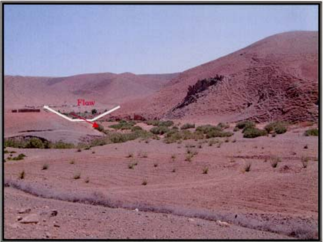
N'Fifikh ダム（下流から）
