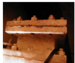
発錆が著しい発電機用冷却器(左：冷却器フィン，右：側面配管接続部<sup>ハット</sup>の腐食)
