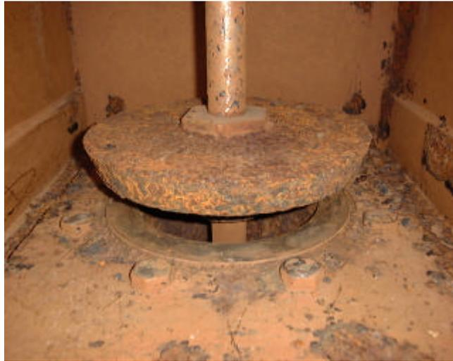
著しい腐食により、止水性能が損なわれた、ストップログのバイパスバルブ
