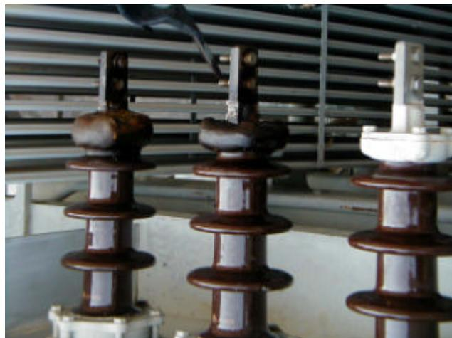
経年劣化による主要変圧器 11kV ブッシングの油漏れの応急処理状況
