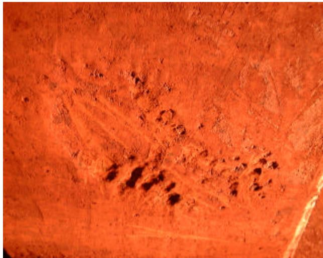
腐食により損傷したステイリング
