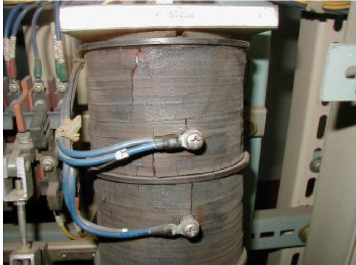
経年劣化の進展による発電機電圧調整器用電磁開閉器コイル絶縁物のひび割れ
