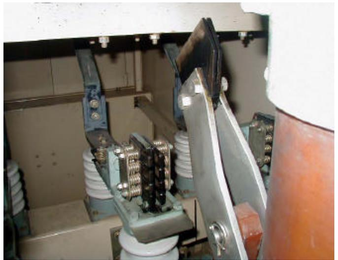
経年劣化による可動部の摩耗，変色が著しい11kV 発電機キュービクル内遮断器,断路器
