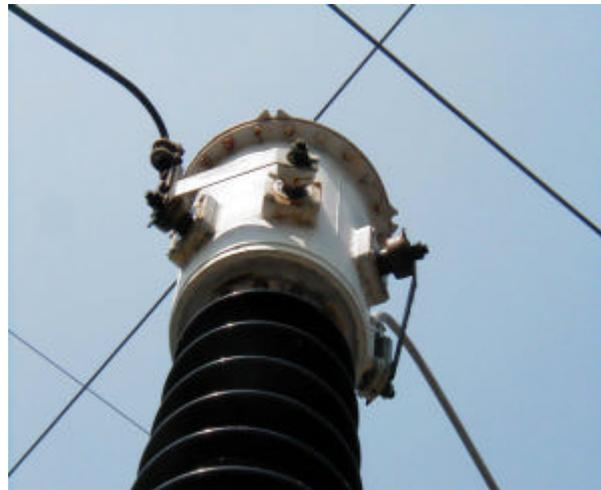
115kV1号送電線用変流器の経年劣化によるパッキン腐食により漏油
