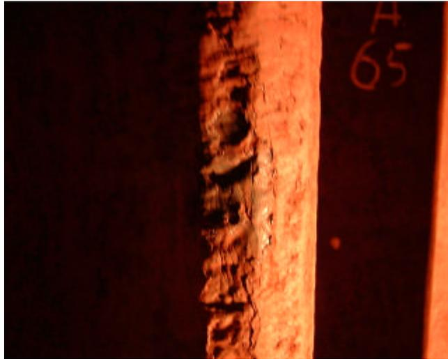
腐食により欠損しているステイベーンの先端
