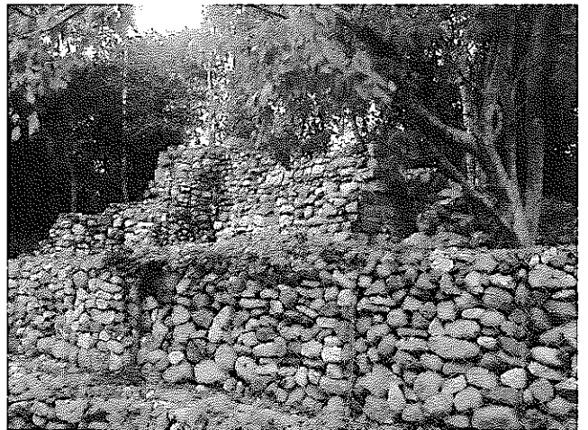
7-4 ハリケーンにより削られたマヤの住居跡と修復、補強された布団かご(コパン遺跡公園 ラス・セブルトゥラス地区)
