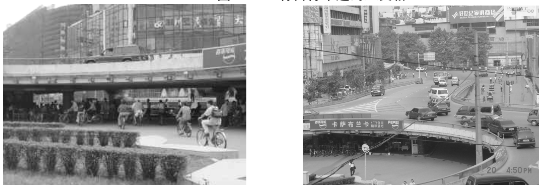
图 3.4.3 有自行车道的立交桥
