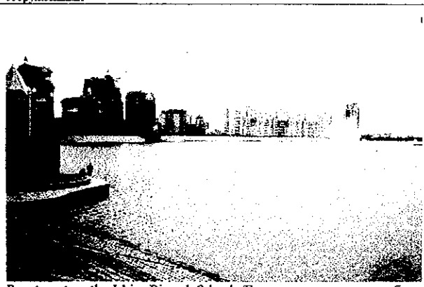
Revetment on the Ishim River left bank / Бетонное покрытие дамбы на левом берегу р.Ишим
