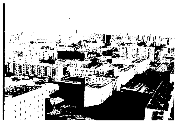
7~9階建てアパートがならぶ中央住宅地域
