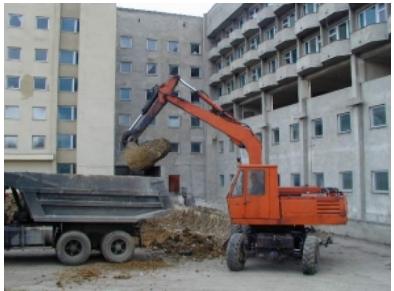
改修工事の状況 (グドゥヤリ総合病院)
