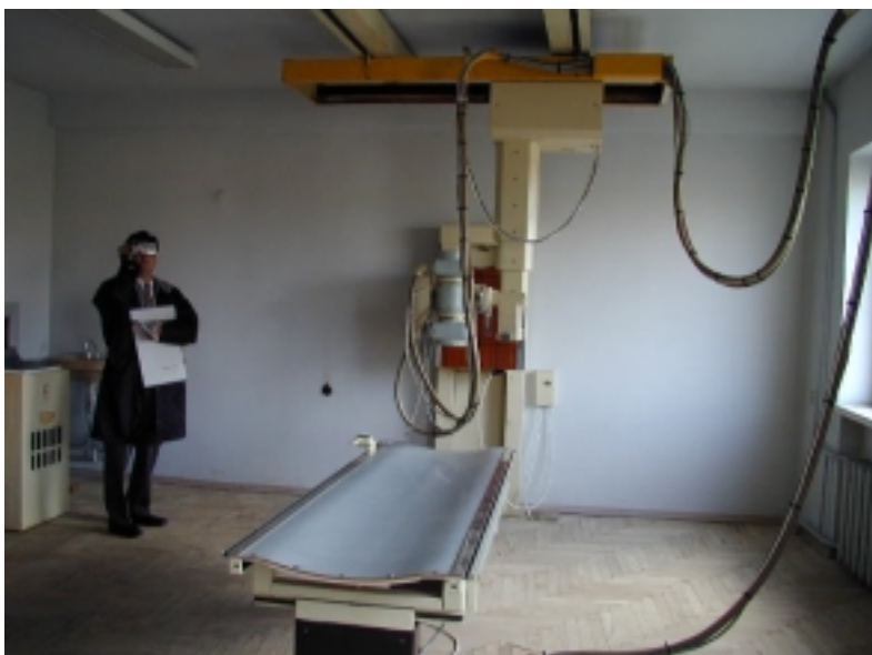
故障中の X 線撮影装置 (グドゥヤリ総合病院)
