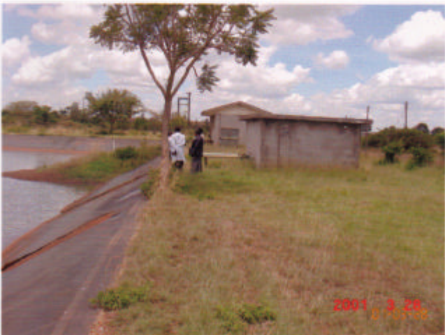
既存のJKUAT貯水池で、過去にアオコ発生による水不足の問題が生じている。
