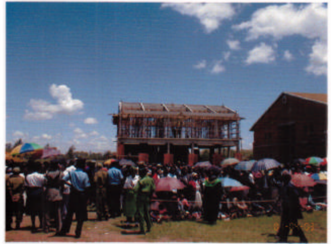
現在、プロ技協のプロジェクト立仕上げ時に使用する施設が建設中である。
