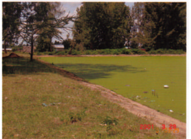
既存のJKUAT酸化池。周辺住民に対する悪臭の問題が出ている。
