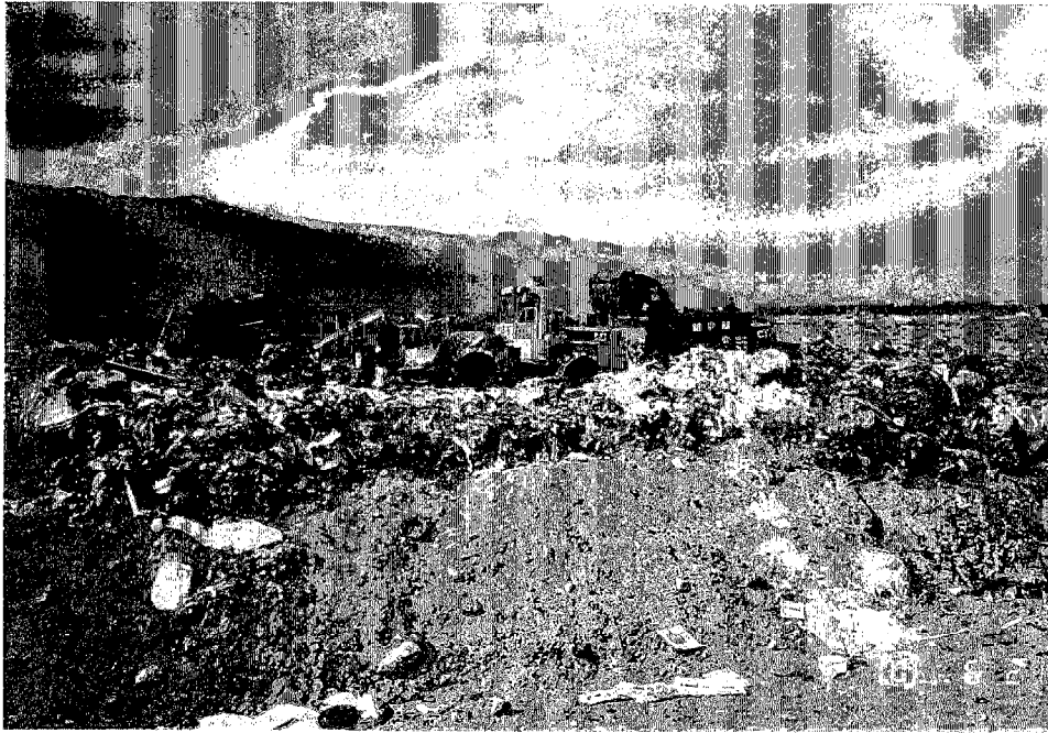
首都近郊のリバートン最終処分場（ジャマイカ）。搬入されたごみの均平、加重が行われている。
