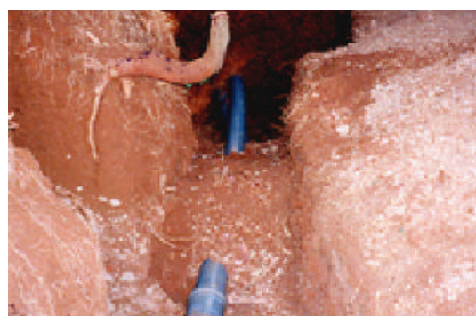
ガタボラ河川導水管および湧泉堰導水管
