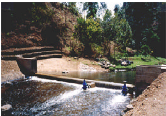
カティタ川取水堰
