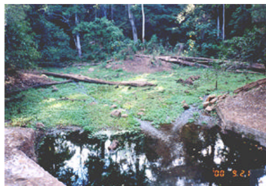
ガタボラ湧泉取水堰および貯水池
