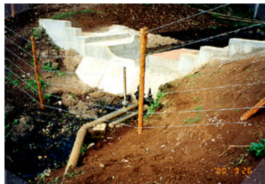
ガタボラ河川取水堰
