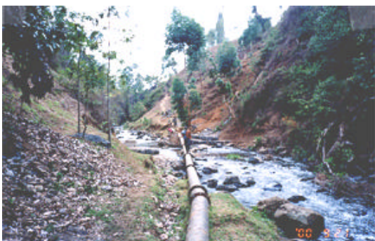
カティタ導水管水管橋
