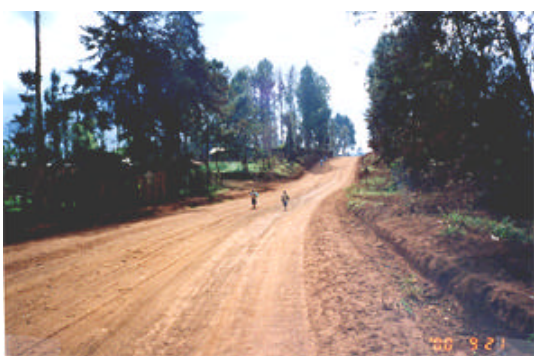
カティタ導水管が敷設されている道路の状況
