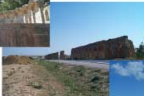
Aqueduc (entre Zagouan et Carthage)
