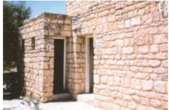
Salle d'accueil comprenant des toilettes, une boutique et un café.
