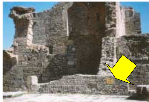
Memmian. En tout une demie-douzaine d'écriteaux sur tout le site. Des panneaux d'explication donnant des informations précises devraient être aménagés
