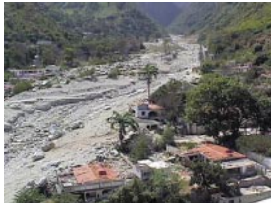
「防災対策」プロジェクト形成調査（ヴェネズエラ）。集中豪雨による土石流災害の復旧計画、防災計画立案のための調査を実施
