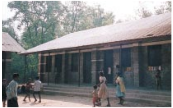
無償資金協力で建設されたネパールの小学校
