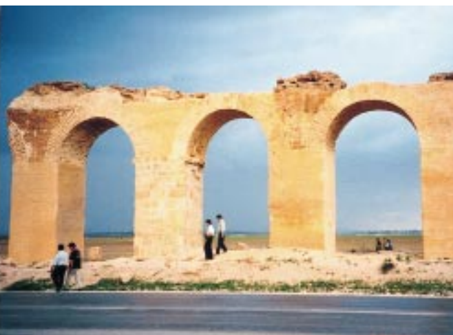
チュニジアの水道橋遺跡。国道脇にあり、車両による振動と風圧で崩壊が進行している
