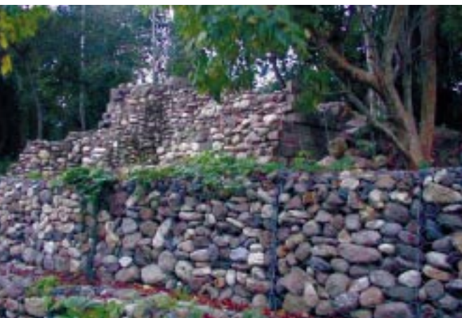
ハリケーンで削られたマヤの住居跡と、修復、補強された布団カゴ（ホンデュラス・コパン遺跡公園のラス・セブルトゥーラス地区）
