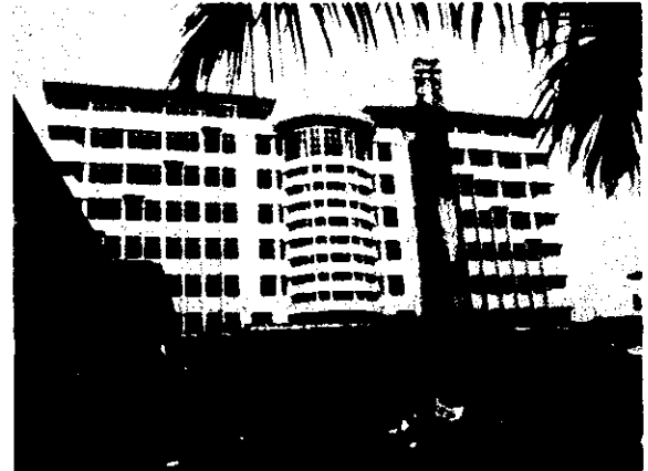
建設中の衛生学校新校舎
