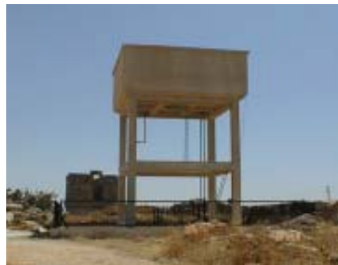
村落内給水タンク
