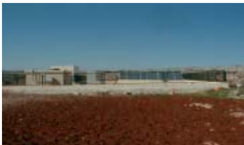
揚水システム全景
