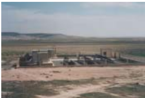
Kalif 村淡水化設備全景
