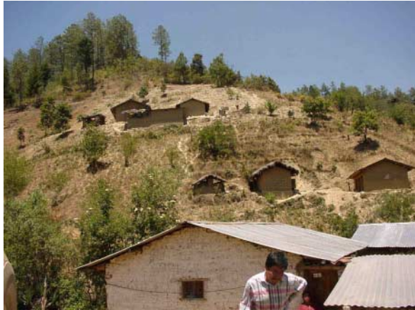
Condición actual de casas
