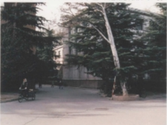
既存のセンターをアプローチ道路より見る。1950年代建設の建物は老朽化が進み、機能的にも施設構造的にも限界に達している。
