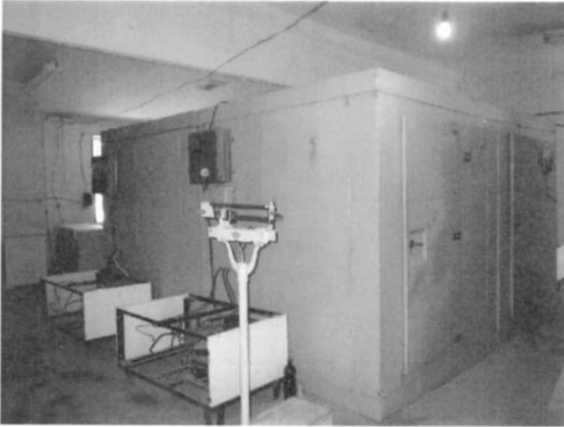
No. 1 共和国SESのワクチン保管用冷蔵庫
