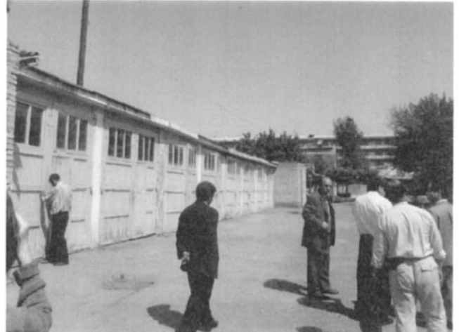
No. 2 ワクチン用保管倉庫
