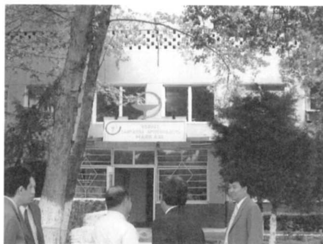
No. 6 州SES外観
