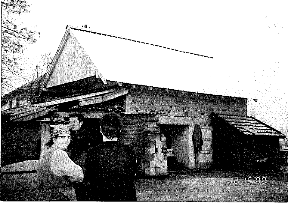
「JEN」が修理した家畜小屋。屋根の部分が新しい
