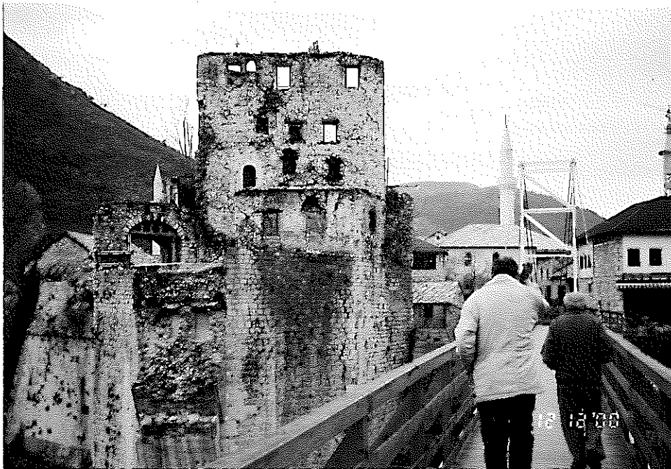
現在はスターリ橋の隣に応急の木の橋が造られている
