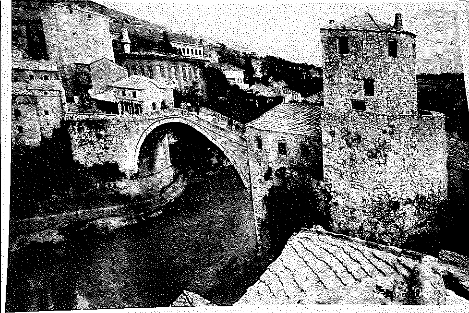
破壊前のモスタルのスターリ橋（中央のアーチ部分がそっくり消えた）
