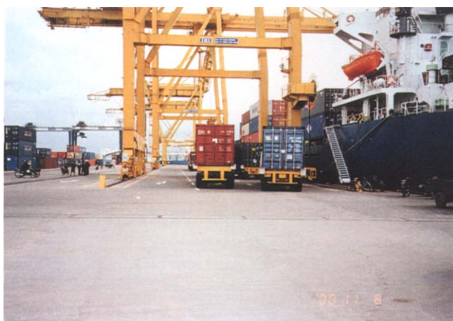
スマラン港 JBIC の融資で建設されたコンテナターミナル
