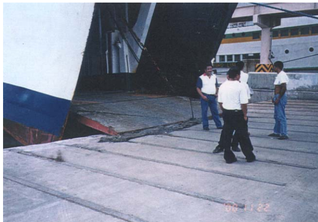
バタンガス港 RORO 船着き場の様子
